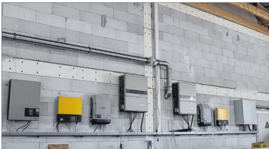
Mithilfe eines Wechselrichters wird aus Gleichstrom-Energie Wechselstrom-Energie gemacht. Bei Tri Watt hängen davon gleich mehrere an der Wand. So können die Fachleute testen, welcher Wechselrichter am geeignetsten ist.
